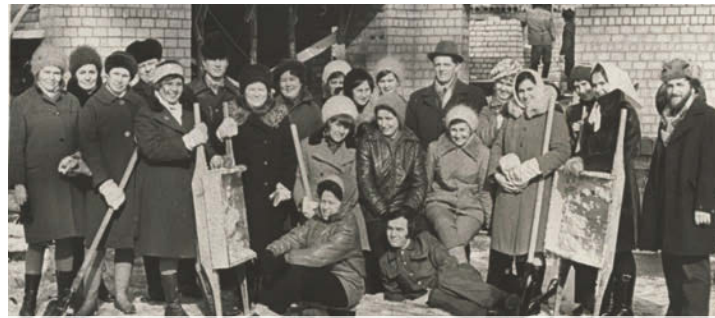
Сотрудники радио на строительстве радиотелецентра. 1978 год
