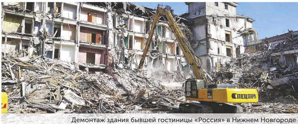
Демонтаж здания бывшей гостиницы «Россия» в Нижнем Новгороде
