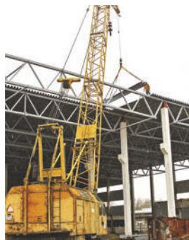
Строительство корпуса производственного цеха
