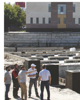
Строительная площадка нового завода
