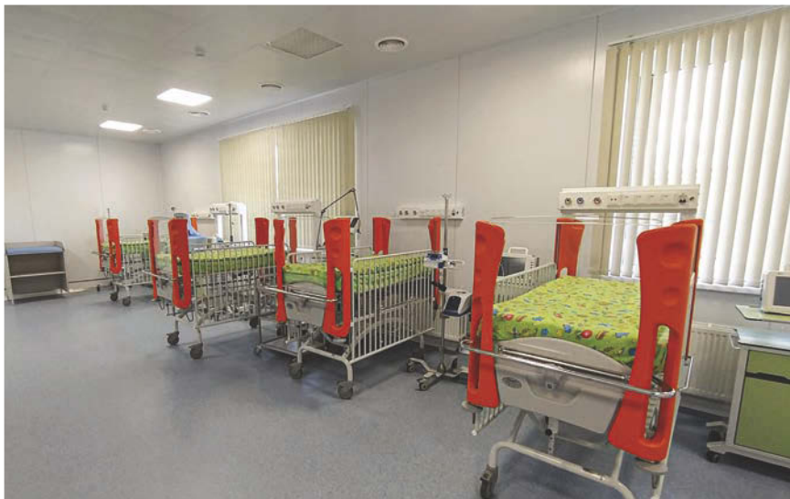
Комплекс чистых помещений для инфекционной клинической больницы № 23 Нижнего Новгорода
