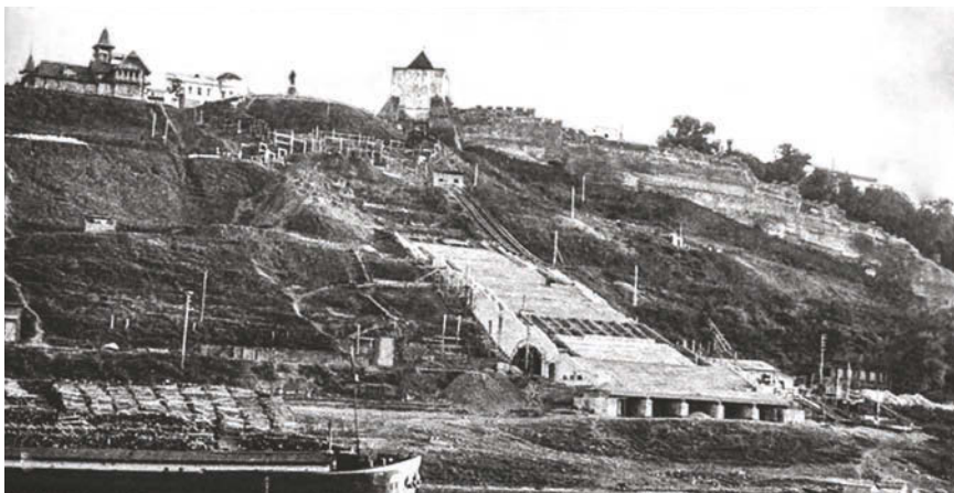
Строительство Волжской/ Сталинградской/Чкаловской лестницы. 1947 год
