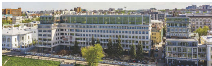
«СТРОЙКОМ-НН» участвует в строительстве жилого комплекса «Георгиевский». Апрель 2022 года
