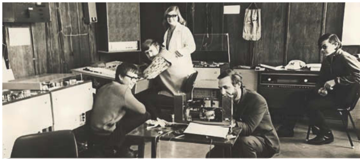
Монтаж оборудования студии звукозаписи в Доме связи. 1973 год
