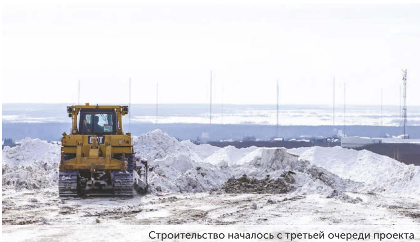
Строительство началось с третьей очереди проекта
