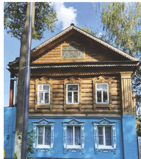
Пять исторических домов в центре Арзамаса восстановлены с участием волонтеров
