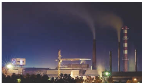
Сотрудники СМУ № 1 занимались реконструкцией Омутнинского металлургического завода
