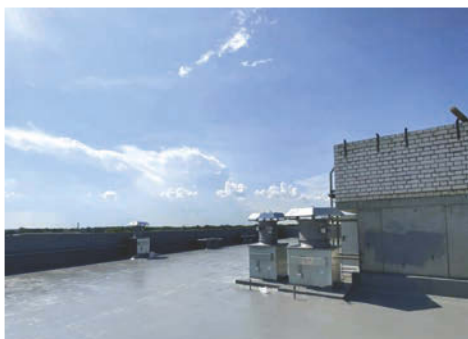
Кровля бизнес-центра на Комсомольском шоссе Нижнего Новгорода
